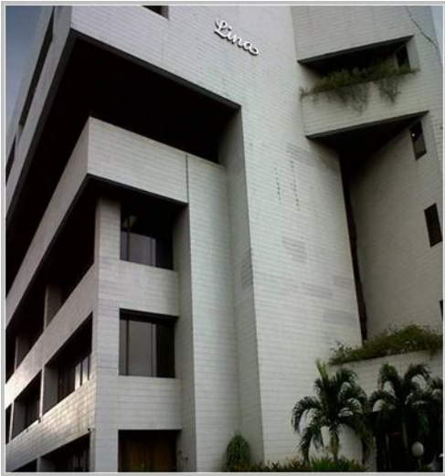
(RASUNA) GEDUNG LINA
