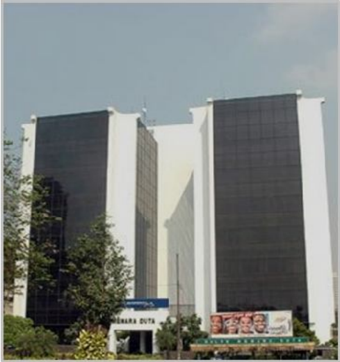
( RASUNA ) MENARA DUTA
